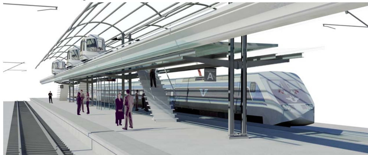
Vid ändstationerna/pendeltågsstationerna läggs spårbilsplattformen ovanpå befintlig perrong.
